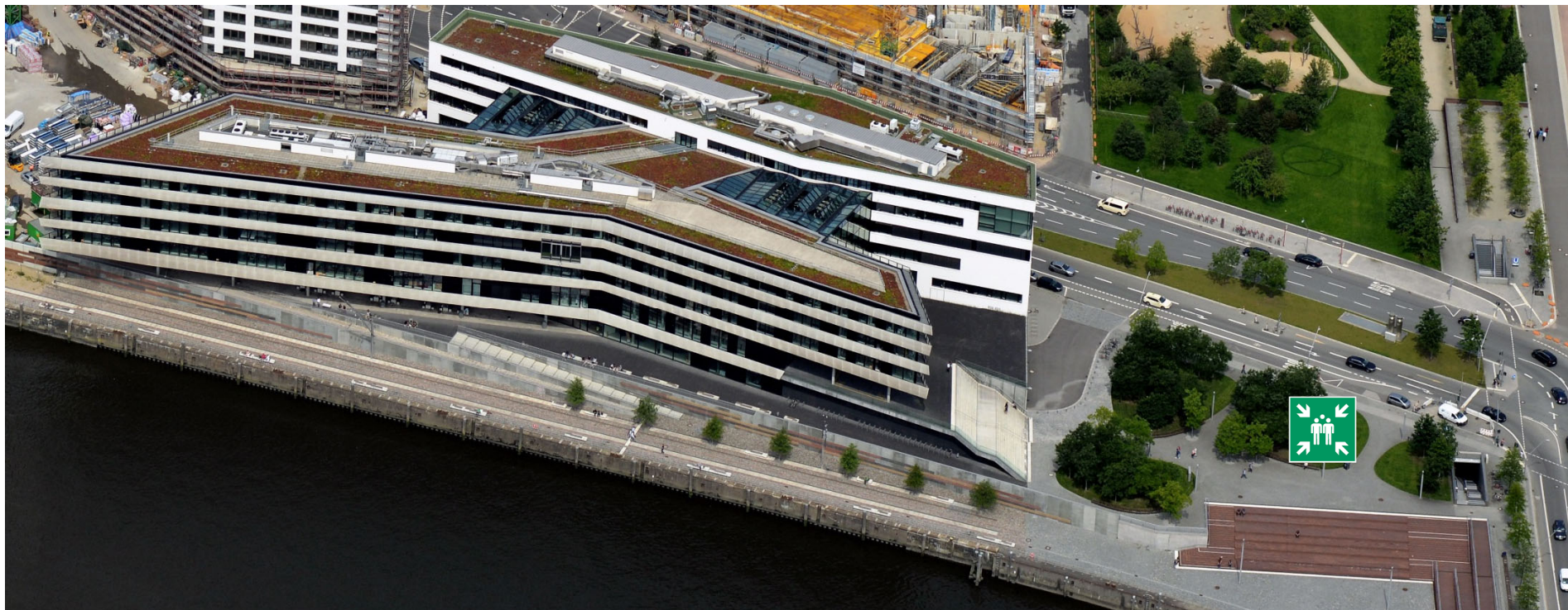
Foto: HafenCity GmbH
