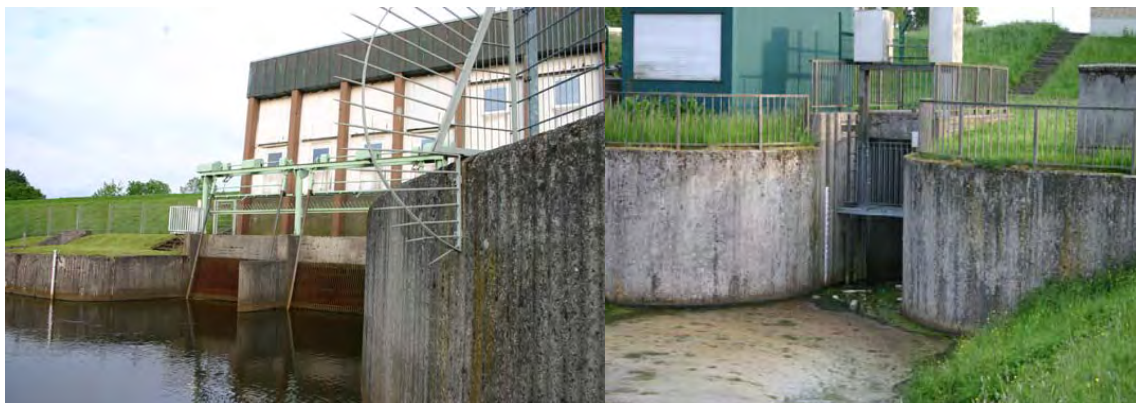
linkes Bild: Schöpfwerk und Deichsiel Finkenriek, rechtes Bild: Nordseite des Neuen Brausiels
