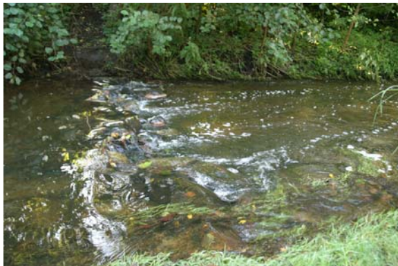
Abbildung 2.66: Steinschüttung an der Wandse (eigenes Foto)
