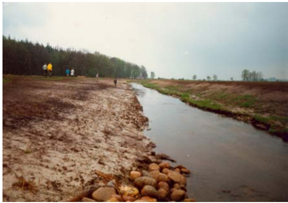
Abbildung 2.9: Böschungsabflachungen an der Buckener Au 1988 (Foto StUA IZ)
