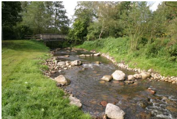
Abbildung 2.14: Sohlgleite in der Dreckau/ Ohlau (eigenes Foto)
