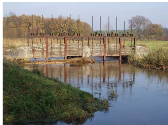
Abbildung 2.15: Wehr bei Benneborstel (eigenes Foto)
