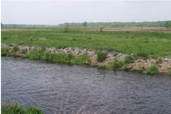
Abbildung 2.80: Ufereinfassung in Spritzbetonbauweise an der Wümme
