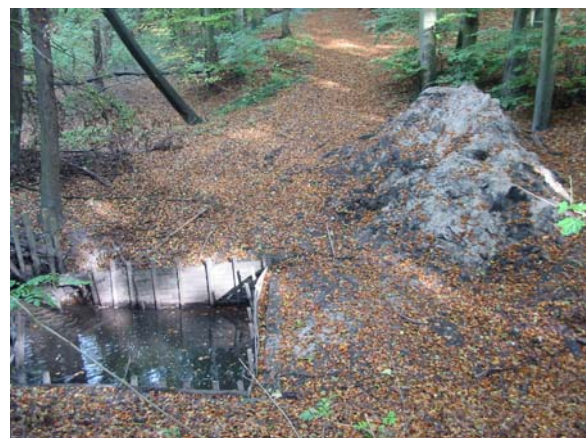
Abbildung 2.51: Sandfang am Börnsengraben mit seitlich gelagertem Aushubmaterial (eigenes Foto)
