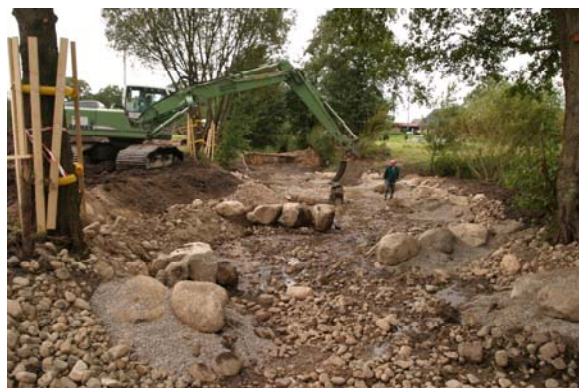
Abbildung 2.12: Sohlgleite an der Dreckau/ Osterau im Bau (eigenes Foto)
