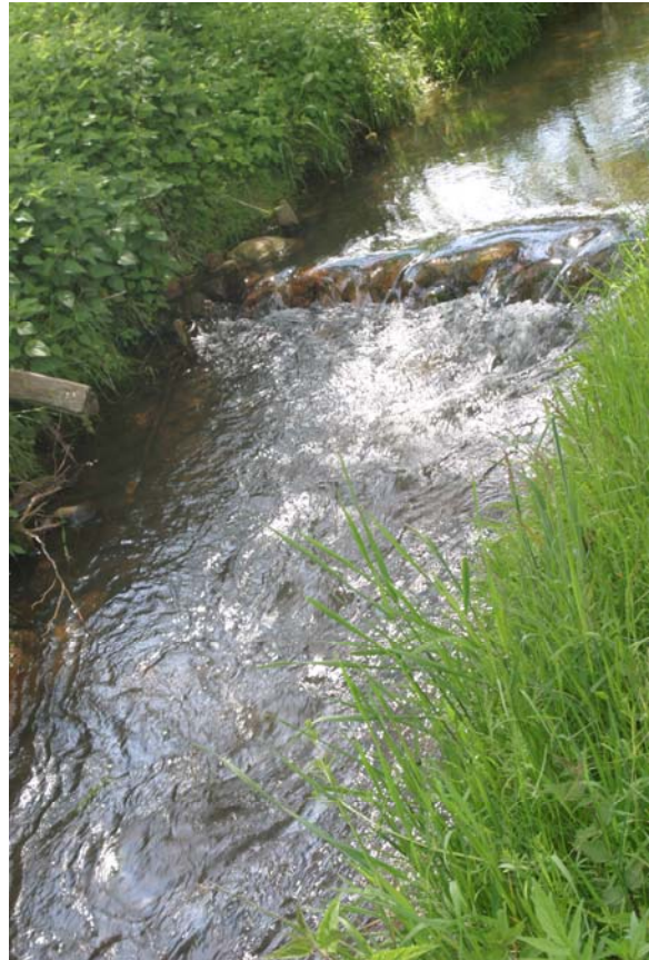
Abbildung 2.65: Grundschwelle am Goldbeck (eigenes Foto)
