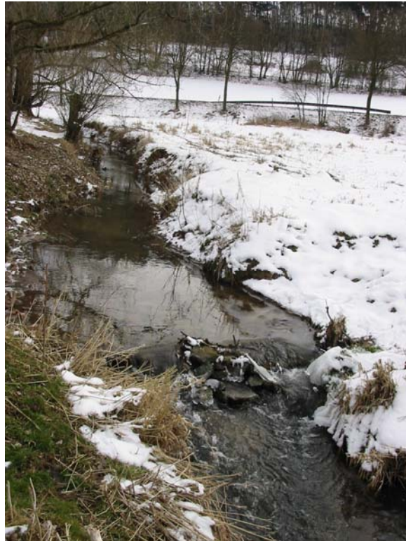
Abbildung 2.67: Sohl-anhebung durch Totholz am Josbach (eigenes Foto)
